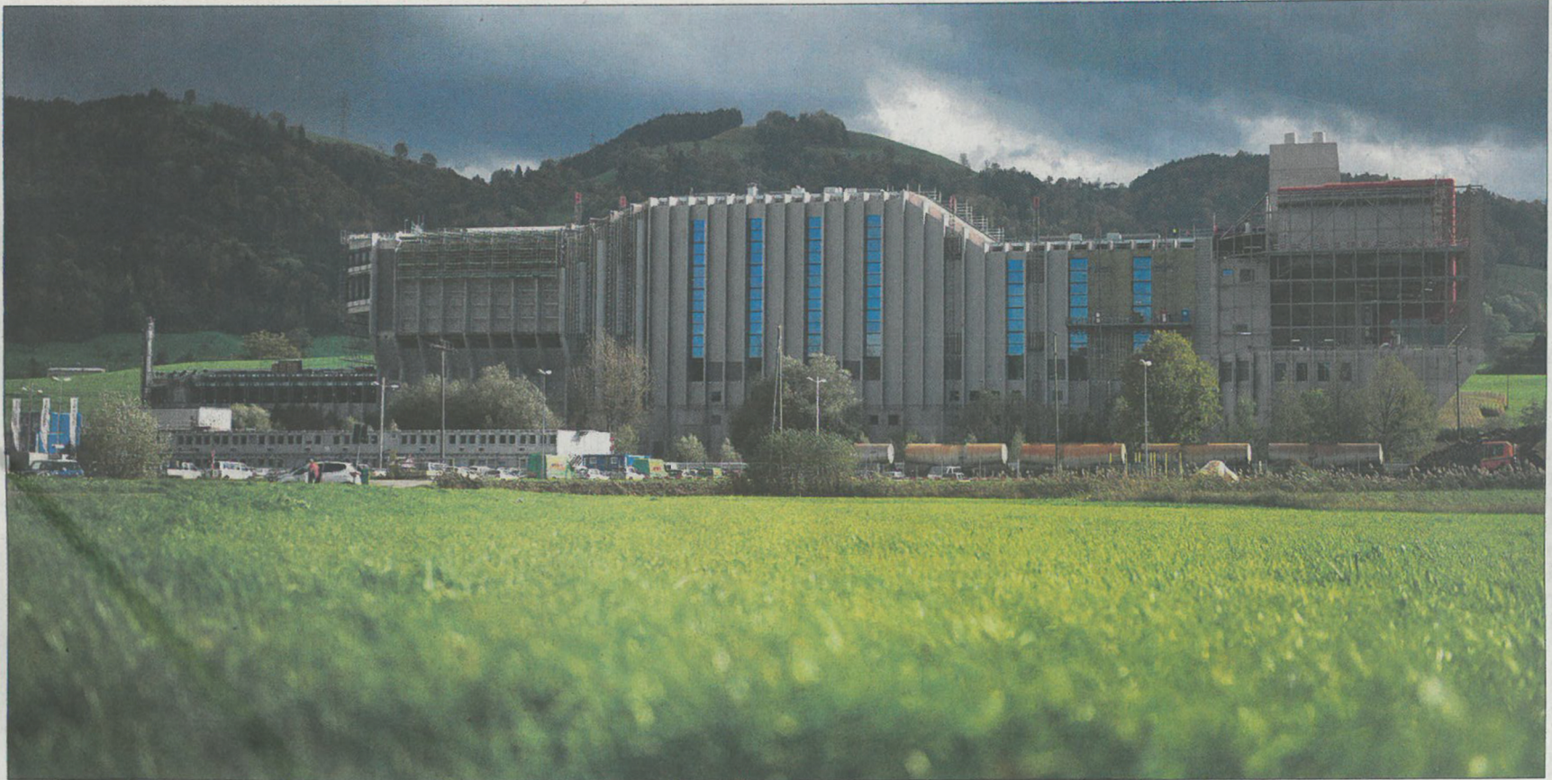
Die Fassade der Kehrrechtverbrennungsanlage Renergia in Perlen wird in den kommenden Tagen fertiggestellt.
